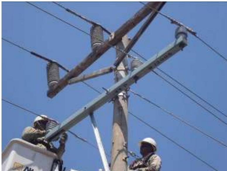
**Figure 7.1:** Power-pole cross-arm<sup>3</sup>
